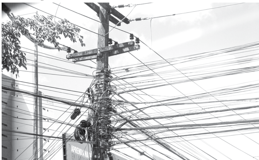
Os postes estão enrolados
